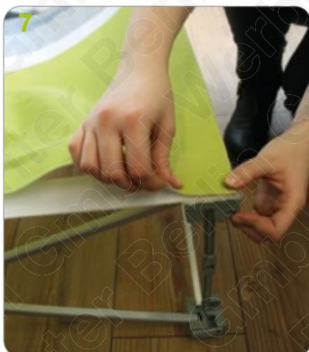
**8** Bringen Sie nun den Druck mit Hilfe des Klettbandes am Gerüst an. Spannen Sie die das Material fest an, damit keine Wellen entstehen.
